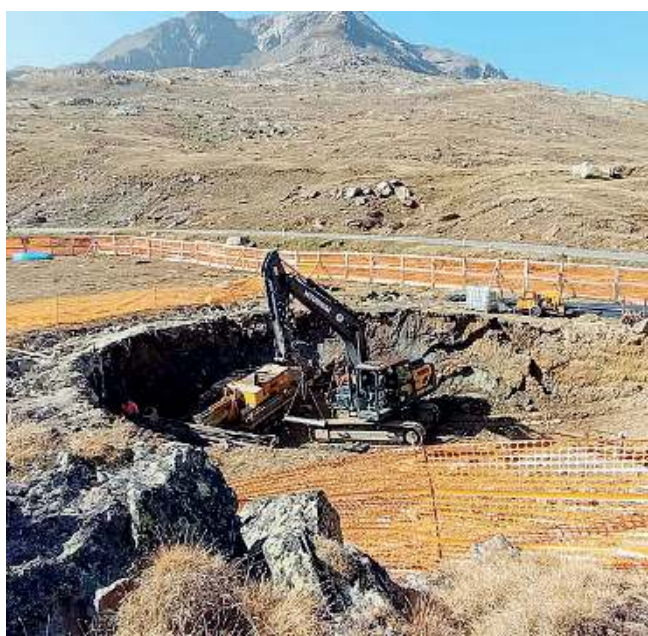
Il cantiere. Gli scavi vicino al lago per l'opera di presa (foto di ottobre)
